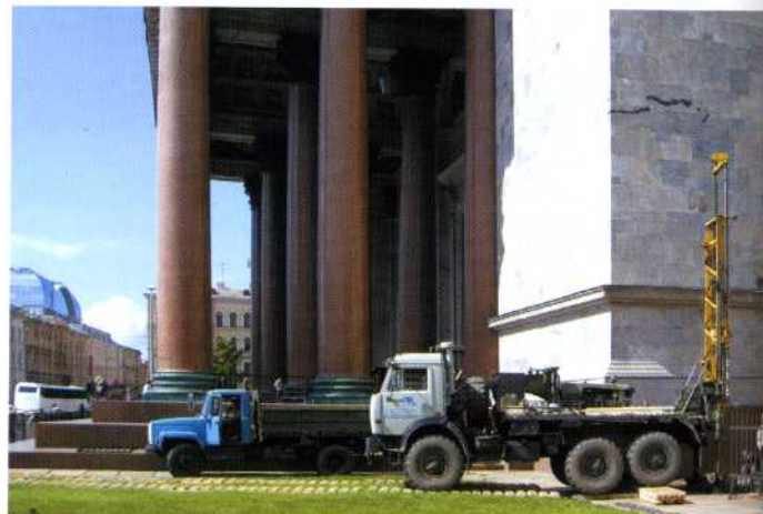
Бурение инженерно-геологических скважин для получения необходимой информации по грунтам основания Исаакиевского собора
