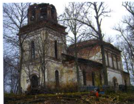
Церковь в дер. Воскресенское Ленинградской области (лазерное сканирование с составлением обмерных чертежей)
